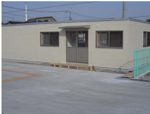
某バス会社運転手詰所 01
