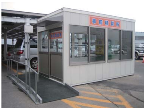
空港駐車場精算所
