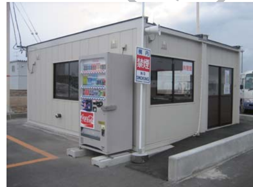
某バス会社運転手詰所 03
