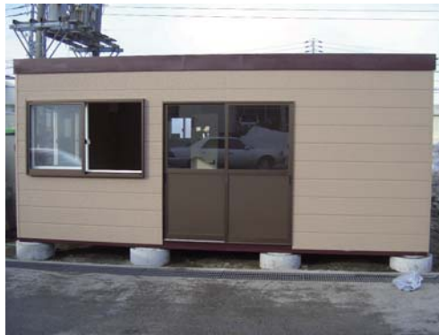
某バス会社運転手詰所 02
