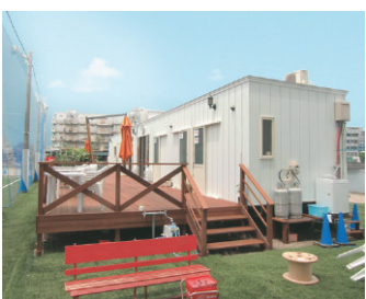
■トレーラーハウス(事務所)
