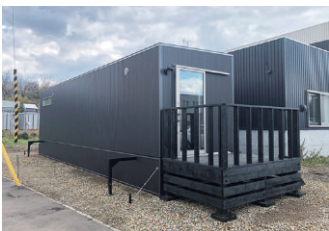
■トレーラーハウス(販売所)
