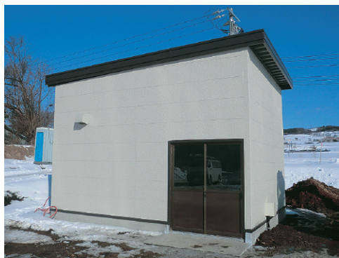
受水槽プレハブ倉庫
